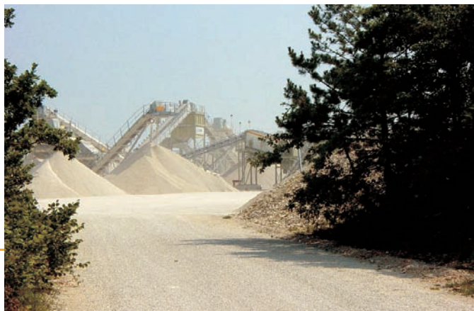
▲ Installations de traitement de Maine-de-Boixe.
