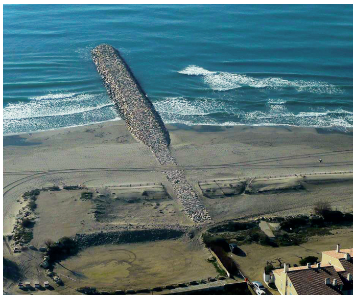
Epi Est des Launes - Digue des Saintes-Maries-de-la-Mer composée de différentes coupures d'enrochement.
